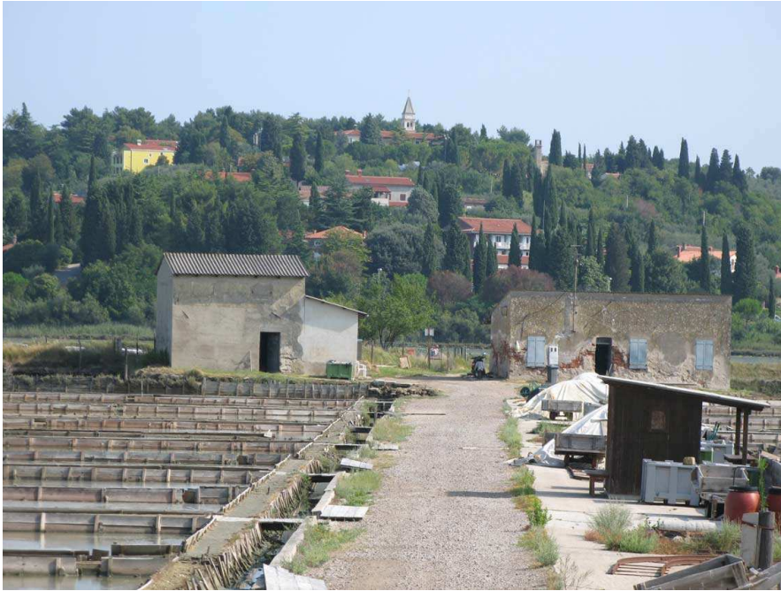
Solinarska hiša pred obnovo
